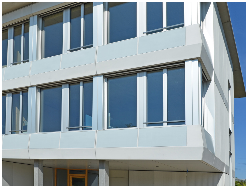
Fassadenelemente mit integrierten PV-Modulen, Bürogebäude in Frick
