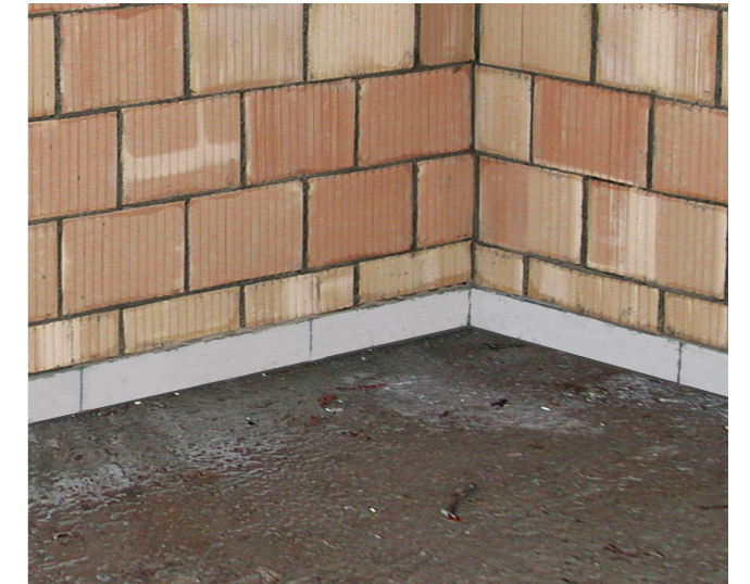
Feuchtigkeit in der Bauphase
