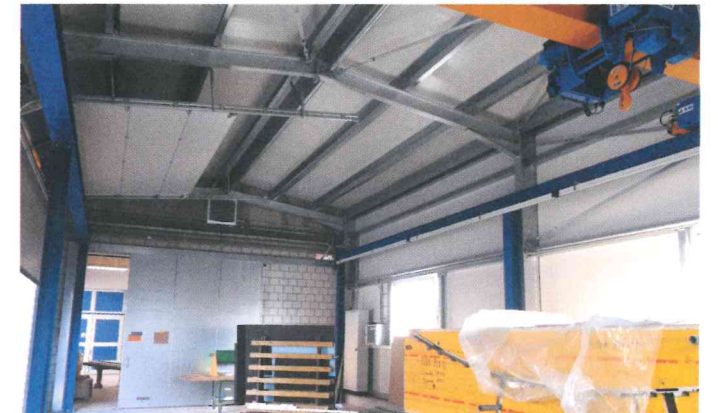
Halle 1 mit bereits montierter Kranbahn und Brandschutzschiebetor
