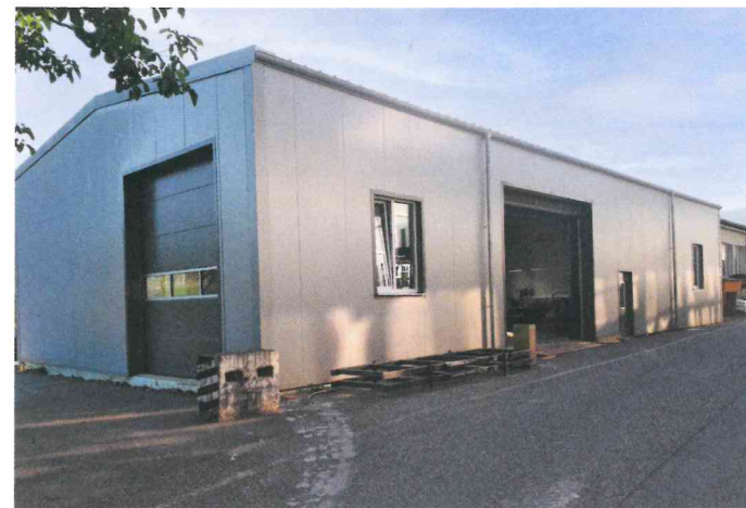
Aufgestellte und montierte Halle 2 der Schlosserei
