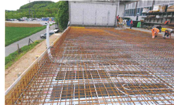
Bewehrung Bodenplatte Halle 2 Schlosserei mit bereits eingelegter Fussbodenheizung
