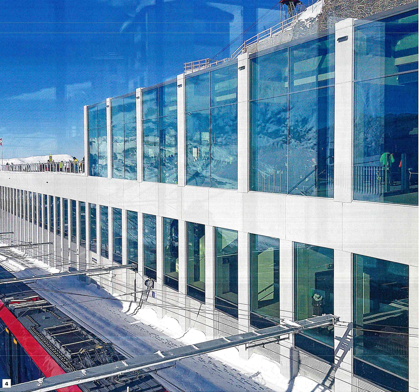
4 Blick von Passerelle auf Jungfraubahn und Südfassade
