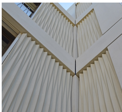
Immeuble collectif, avec triangles imbriqués, Frohalpstrasse, 8038 Zurich
