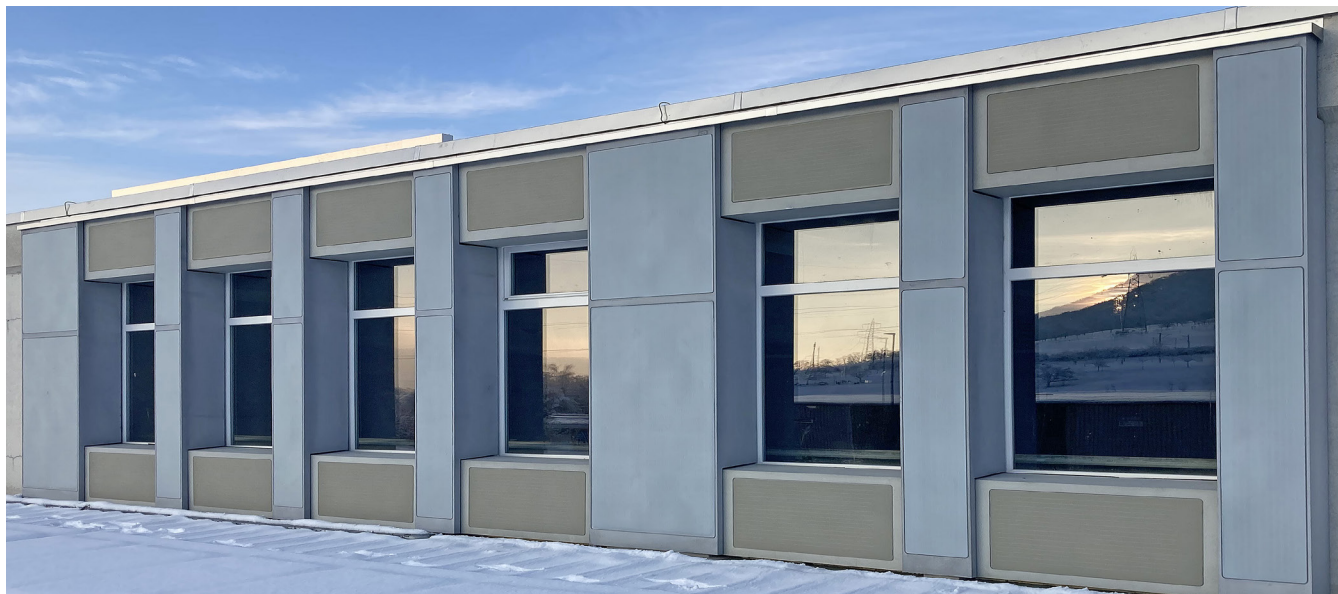
Eléments de façade avec modules PV intégrés à Frick
