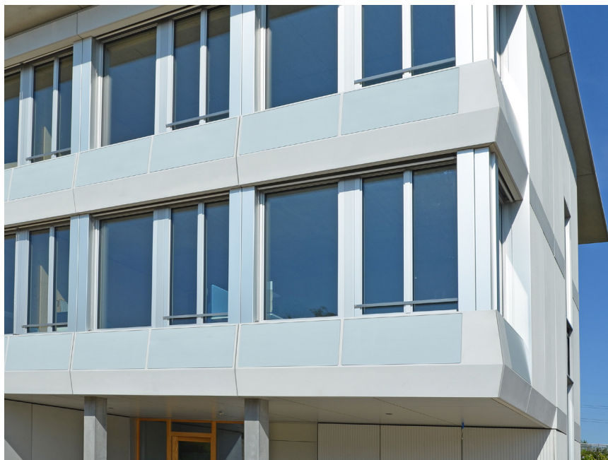
Éléments de façade avec modules PV intégrés sur l'atelier à Frick
