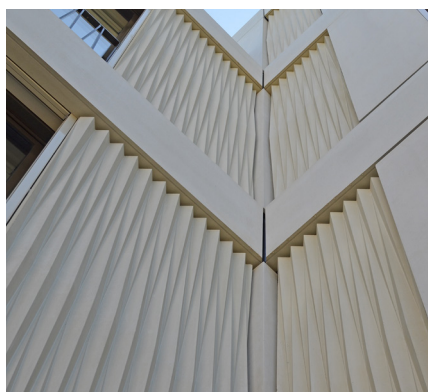
Immeuble collectif, avec triangles imbriqués, Frohalpstrasse, 8038 Zurich
